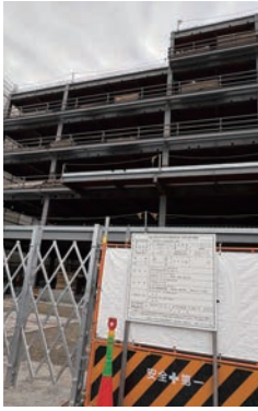
京都での工事の様子
