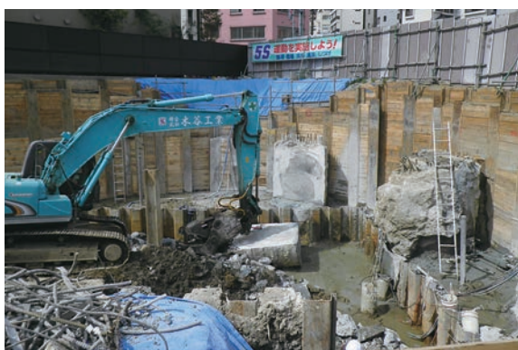
既存杭を撤去する解体工事の様子
