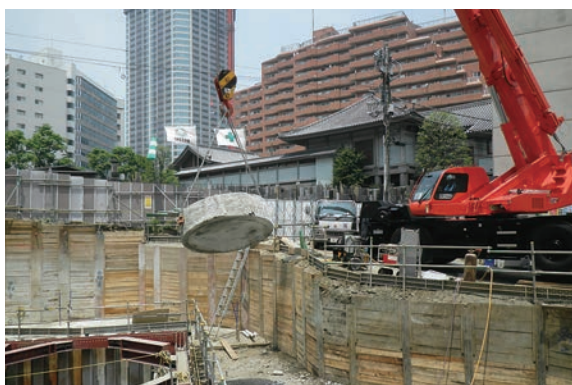
同じく、既存杭を撤去する解体工事の様子
