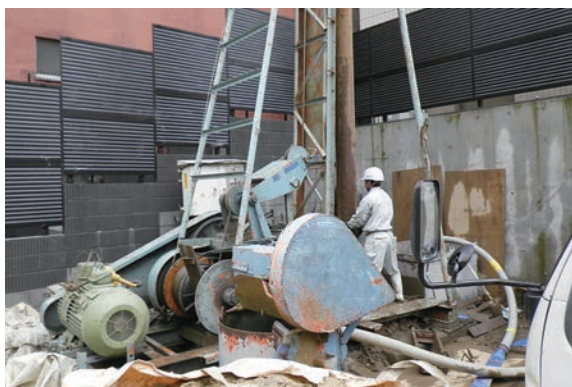
地表から地下の帯水層まで掘り、井戸をつくる井水工事の様子
