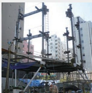
柱と梁の組み上げ工事開始
