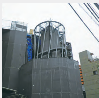
エレベーター棟の螺旋階段設置
